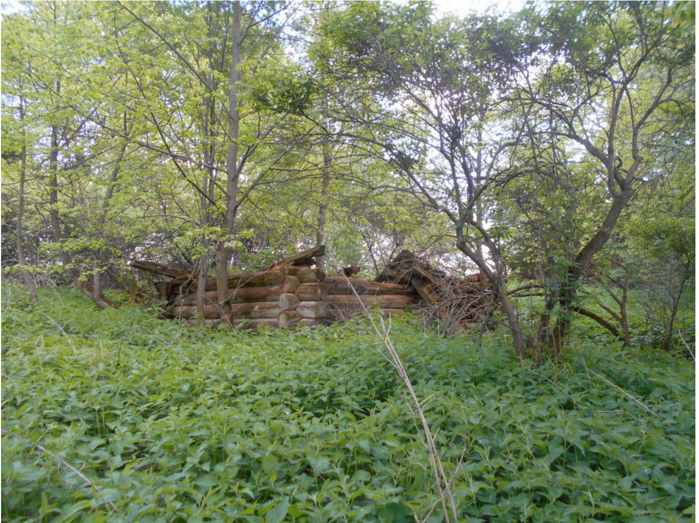
Фото 3. Вид с северо-запада.
